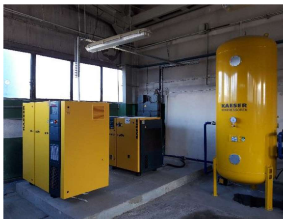
Rysunek 6. Poprawa efektu energetycznego Zakładów Ceramicznych „Bolesławiec” Sp. z o.o. poprzez modernizację instalacji wytwórczej sprężonego powietrza oraz modernizację oświetlenia
