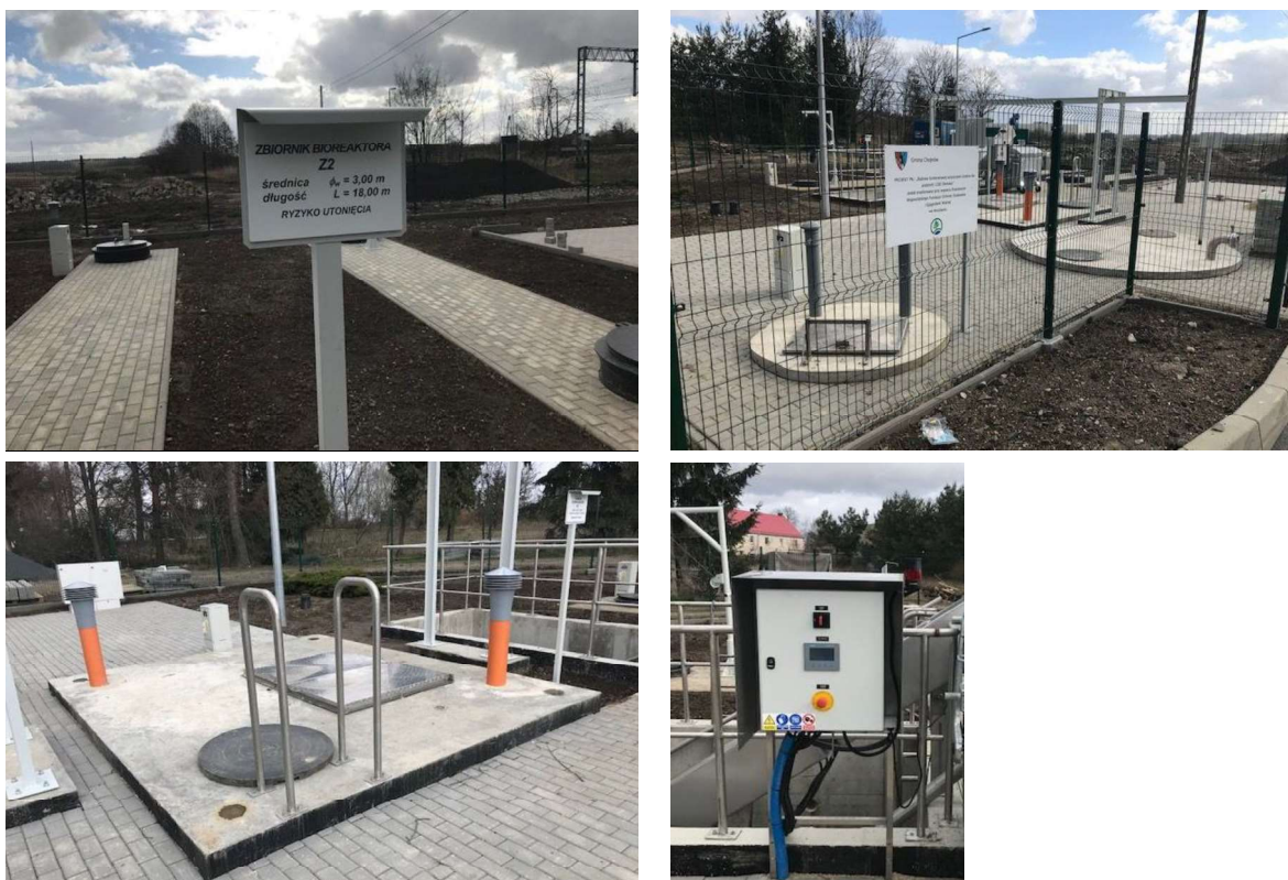
Rysunek 2. Zadanie pn. „Budowa kontenerowej oczyszczalni ścieków dla podstrefy LSSE Okmiany” realizowane przez Gminę Chojnów.
