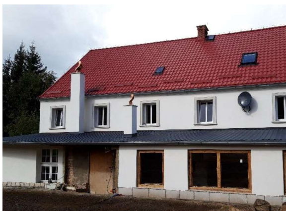
Rysunek 3. Termomodernizacja budynku gospodarstwa agroturystycznego „Kolorowy Raj” w Wieńszowicach
