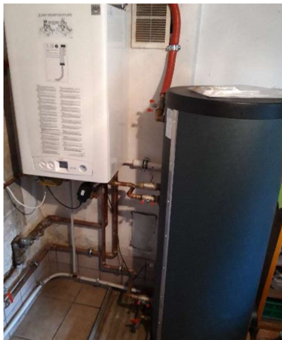
Rysunek 8. Wymiana kotłów stałopalnych starej generacji na przyjazne środowisku źródła ciepła na terenie Gminy miejskiej Piechowice
