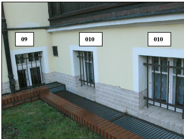
Zdjęcia nr 4. Elewacja od strony dziedzińca wewnętrznego, okna piwniczne.
